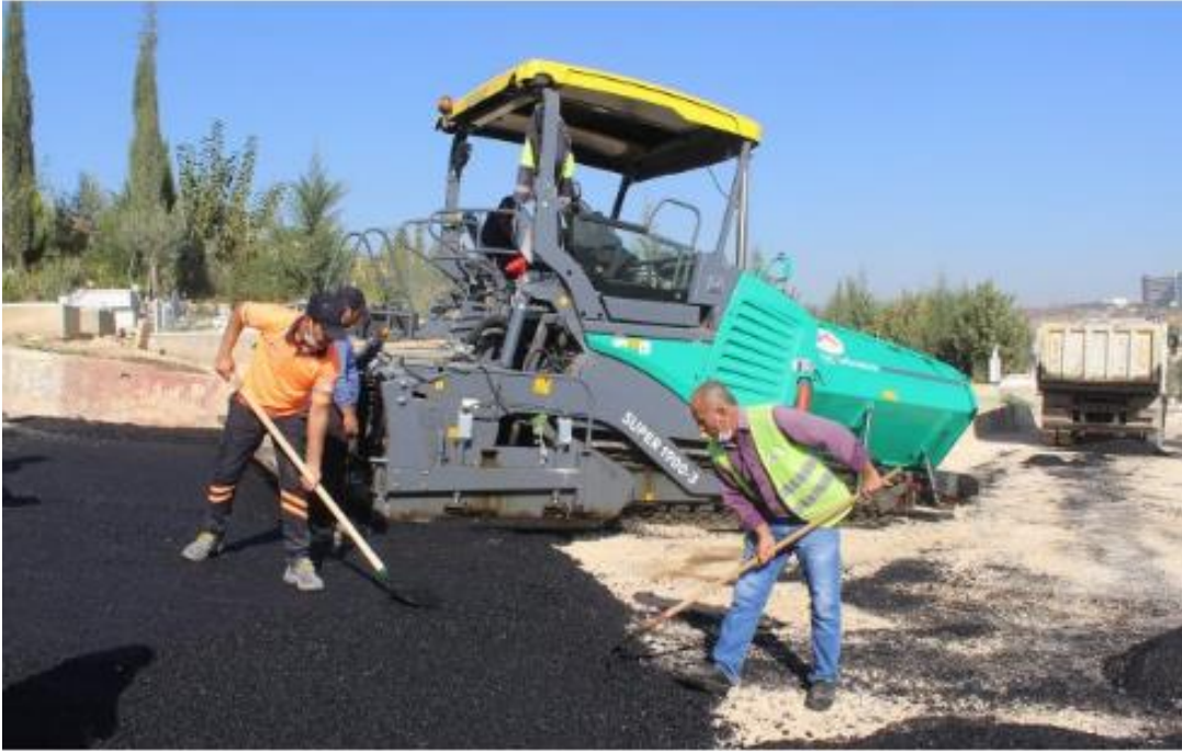
GÜNEYKENT MEZARLIĞI'NDA SICAK ASFALT ÇALIŞMASI
